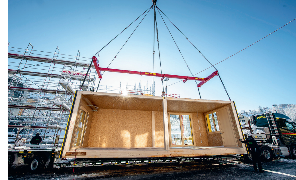
45 Module mit einer Grundfläche von 27,6 Quadratmetern wurden innerhalb von drei Tagen montiert.
