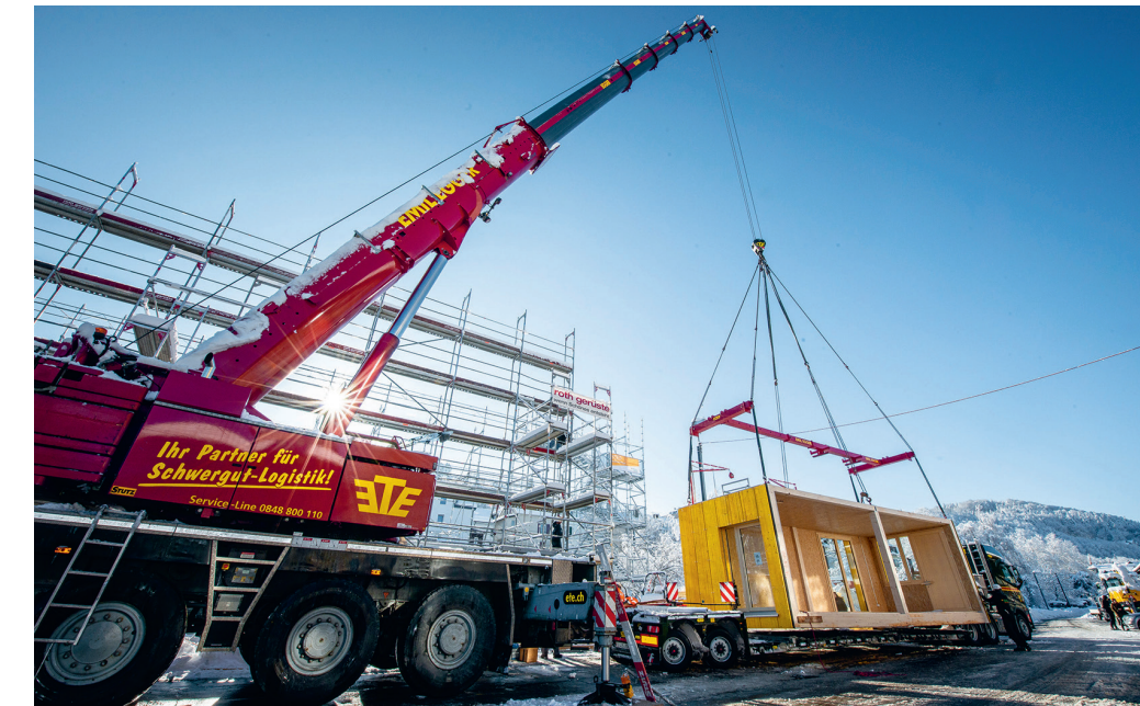
Für die Module ist eine temporäre Nutzung vorgesehen, der spätere Rückbau wurde beim Entwurf berücksichtigt.
