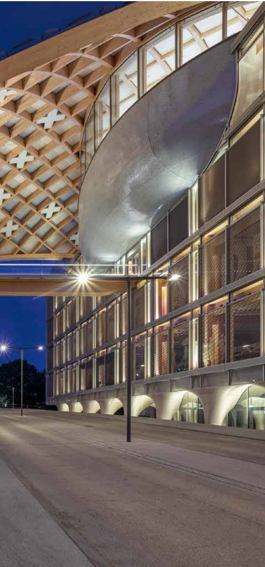
Das Dachtragwerk des Swatch-Neubaus in Biel überspannt eine Länge von 240 Metern
