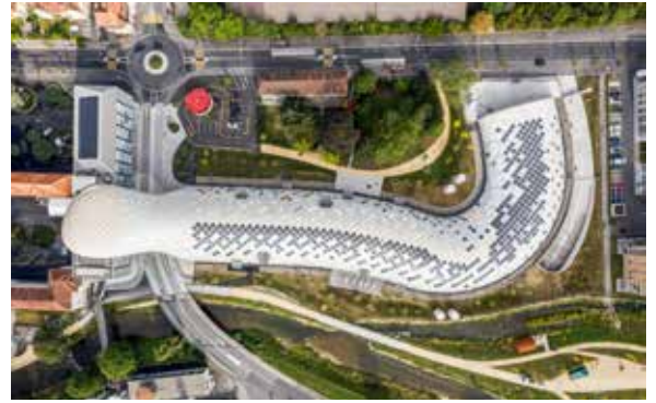
Das Dachtragwerk des Swatch-Neubaus in Biel überspannt eine Länge von 240 Metern
